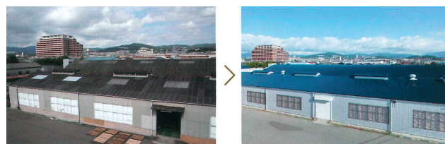
工場建屋の修繕前後
