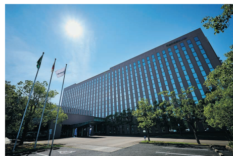
本社内屋外観
