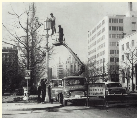
御堂筋街路灯建柱工事中の「イナバ号特車」
